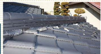
屋根瓦診断箇所(一例)
